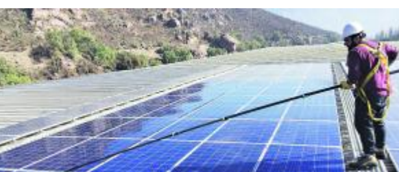
Gestión Solar realizando una limpieza en la planta fotovoltaica de la empresa Andes Quality.
