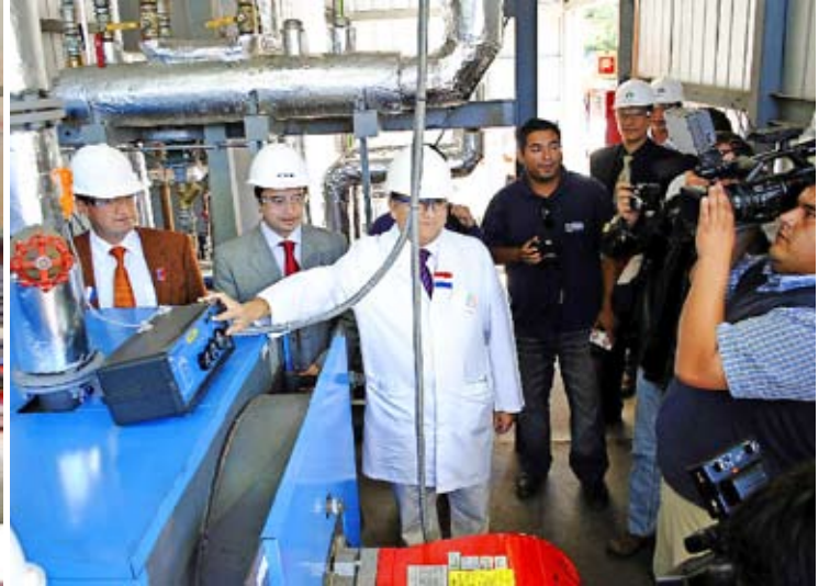
La iniciativa consideró la modernización de las centrales térmicas de los hospitales de Coronel y Lota, mediante la habilitación de nuevas calderas.
